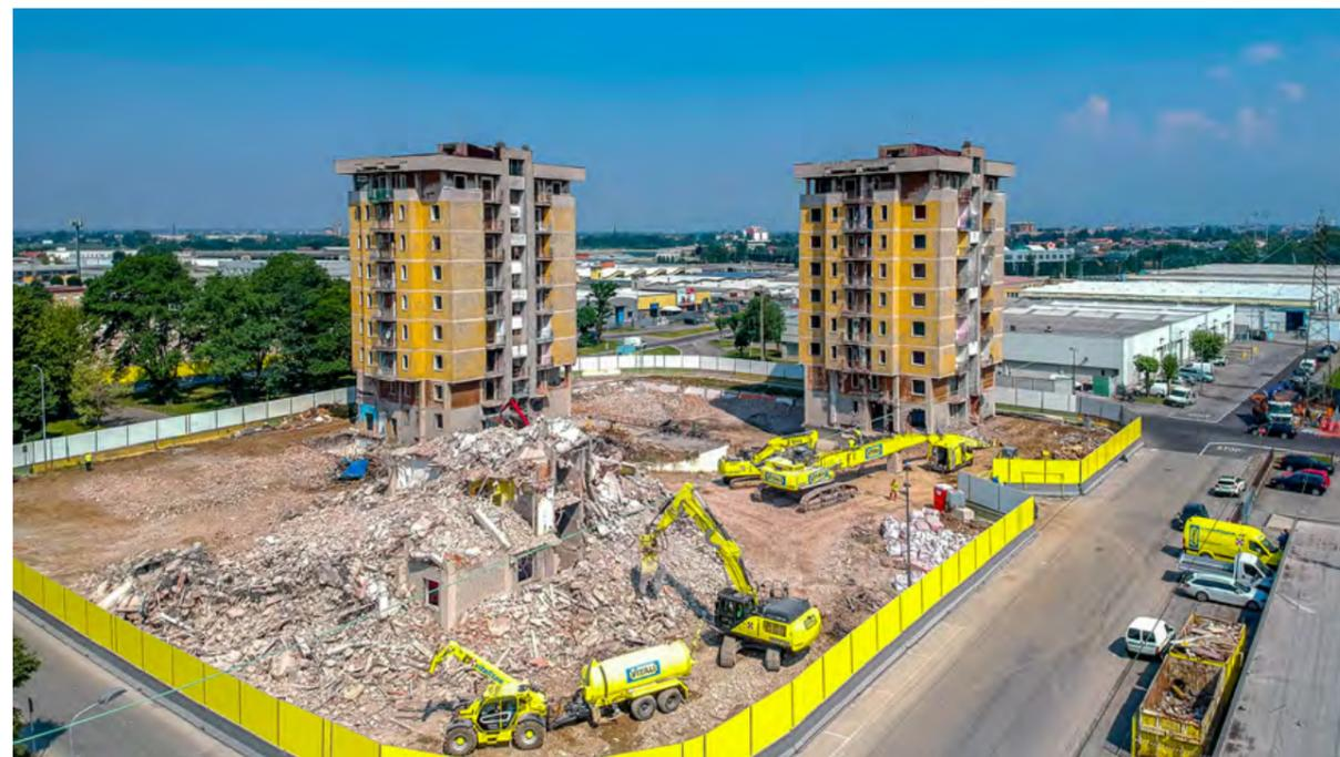
Una **demolizione selettiva** che ha permesso di differenziare già durante l'abbattimento le differenti tipologie di rifiuti. Per prevenire la caduta di macerie al di fuori dell'area di cantiere e per minimizzare la dispersione delle polveri, è stato posizionato un telo di protezione sul fronte strada sorretto da una autogrù e alto quanto le palazzine.
